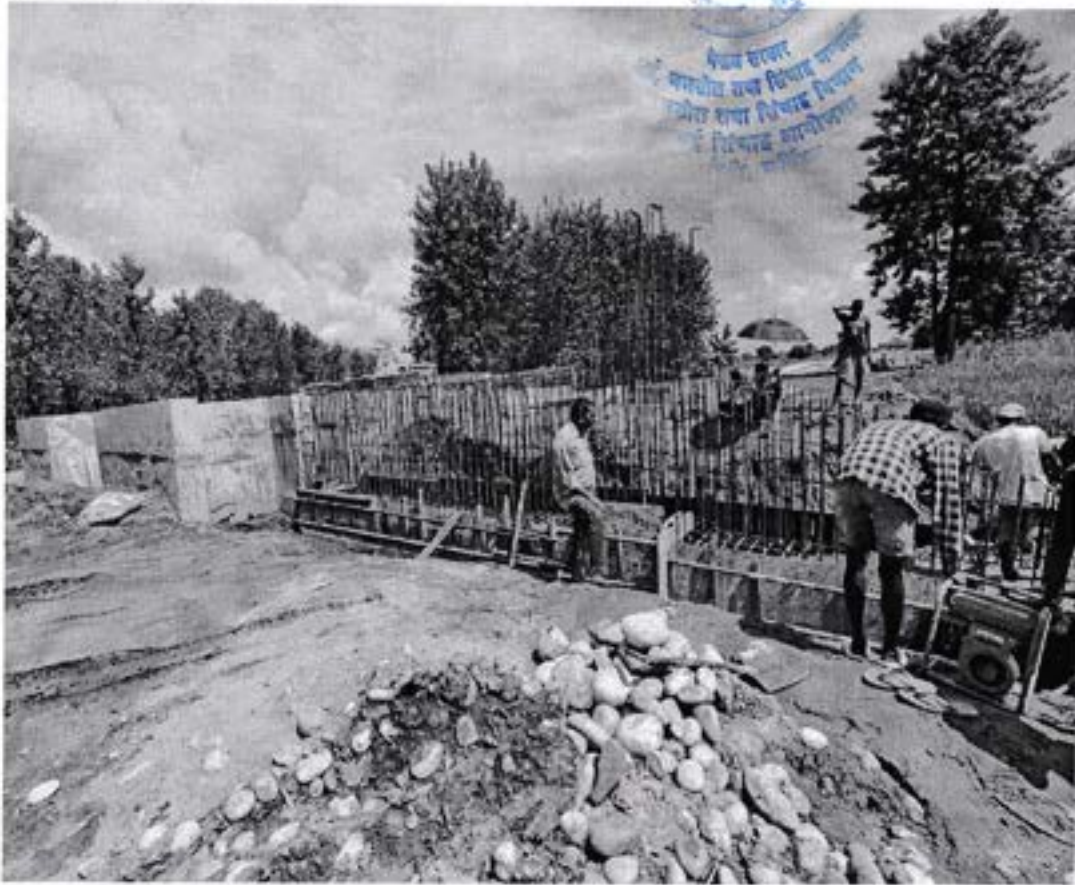
पश्चिम मूल नहर प्रणाली अन्तर्गतको निर्माणाधिन सुहेलवा शाखाको HR-CR (चे. २९+५६०)
