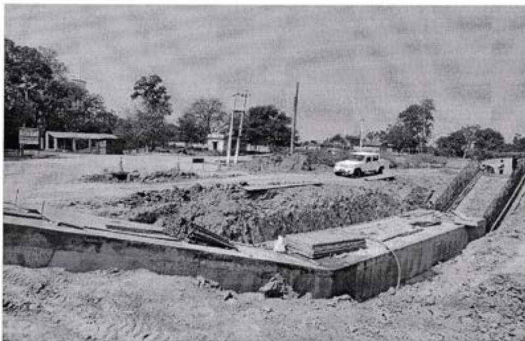
पश्चिमी मूल नहर (चे. २८+०००), पर्वतीया मन्दिर नजिक निर्माणाधिन साईफन
