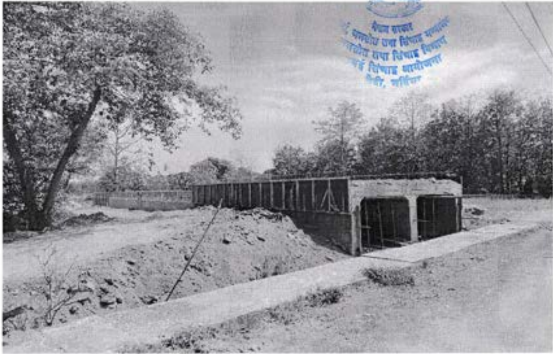
पश्चिम मूल नहर (चे.२९+४००) अन्तर्गतको निर्माणाधिन कर्भर्ड क्यानल
