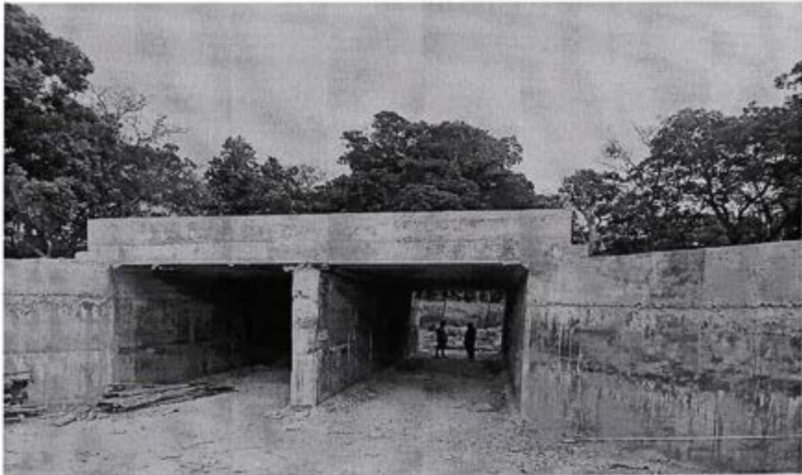
पश्चिम नहर प्रणाली अन्तर्गत उत्तर कुलोको SRI(चे.०+४००) निर्माणाधिन Drain Under Pass
