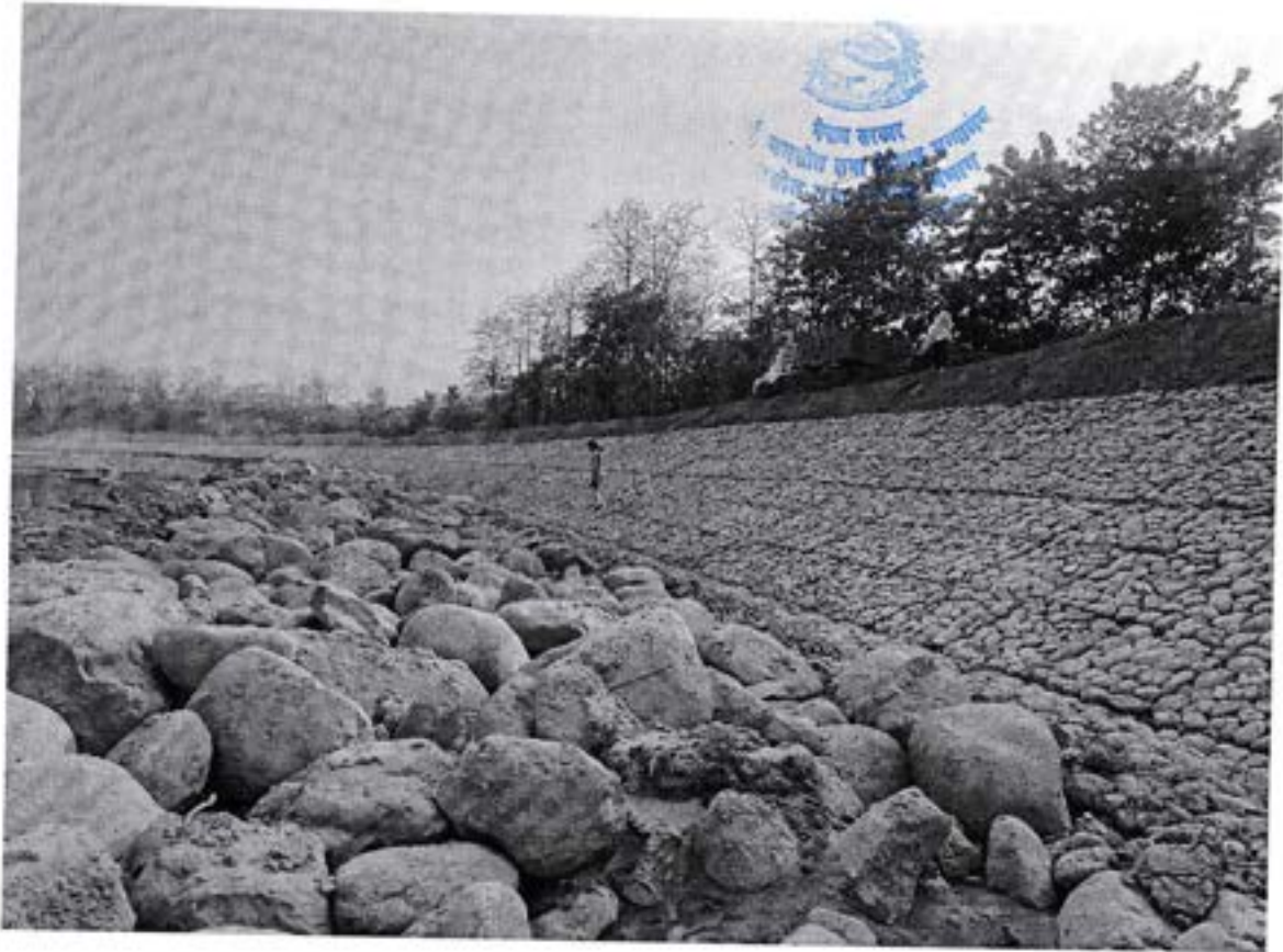
बबई नदि (मधुवन न.पा. ८ कुसुम्बाघाट) को दायाँ किनारामा निर्माणाधिन तटबन्ध
