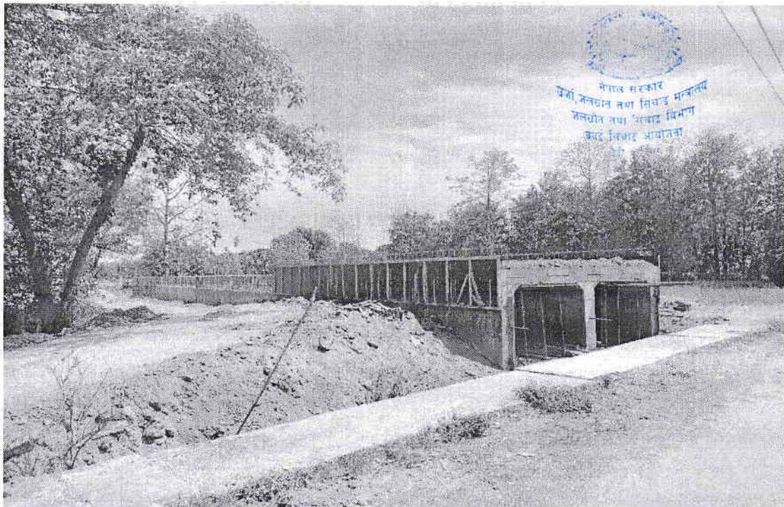
पश्चिम मूल नहर (चे.२९+४००) अन्तर्गतको निर्माणाधिन कभर्ड क्यानल
