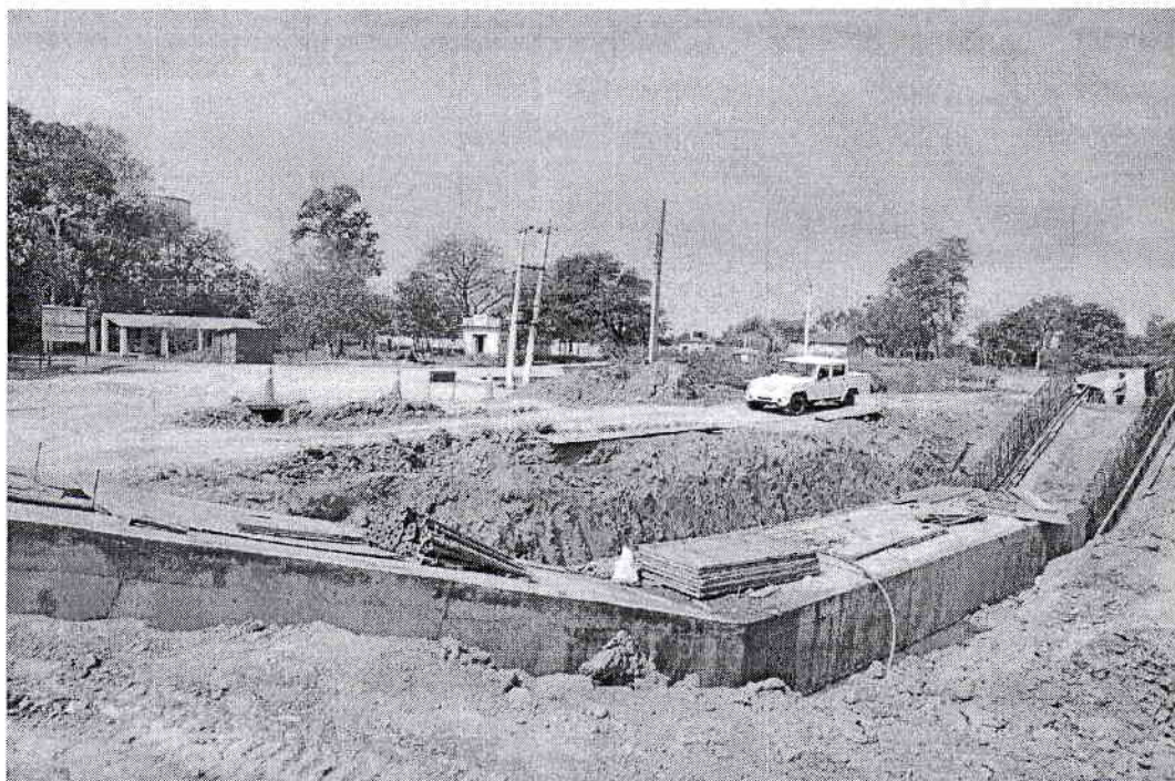
पश्चिमी मूल नहर (चे. २८+०००), पर्वतीया मन्दिर नजिक निर्माणाधिन साईफन
