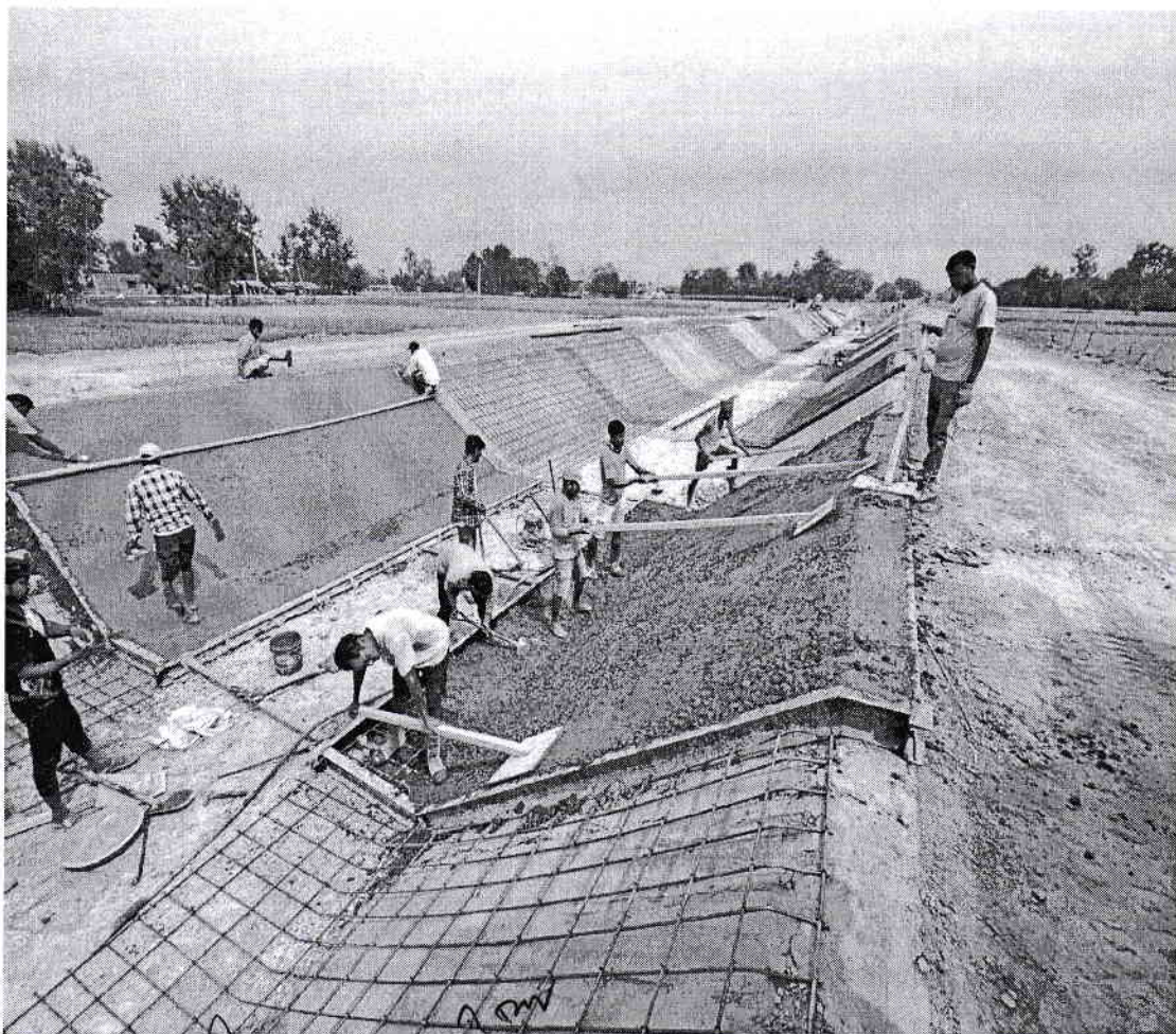
पश्चिम मूल नहर अन्तर्गतको Slope Lining
