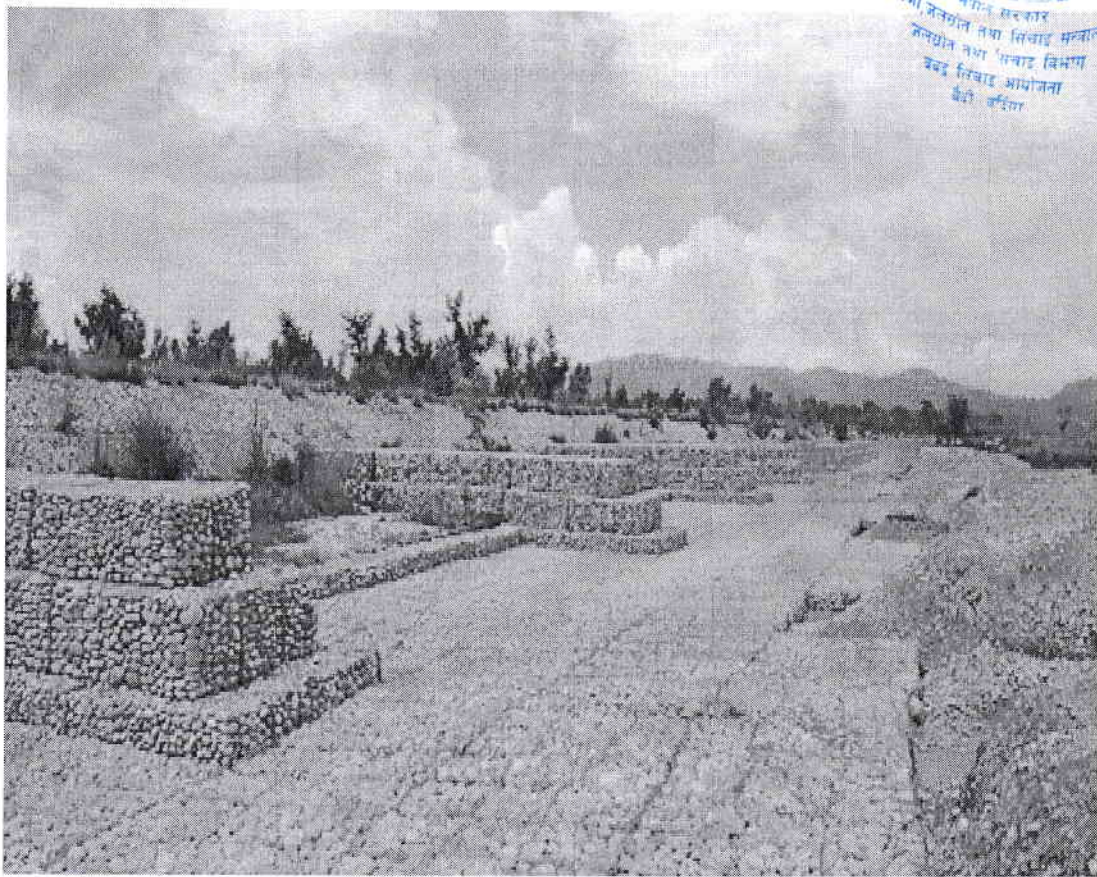
ग्याबिनको प्रयोग गरी तटबन्ध निर्माण / सिंचित क्षेत्र संरक्षण कार्य
